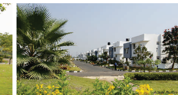
Actual Picture of site
